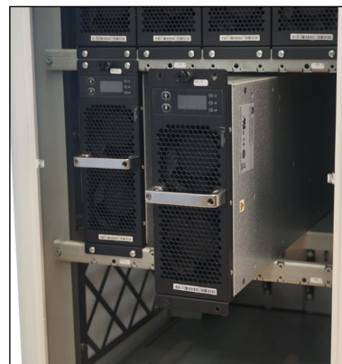
Abb. 56: AC/DC-Module aus-einbauen
