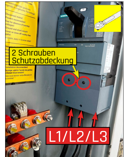
Abb. 37: Anschluss AC-Hauptzuleitung L1/L2/L3
