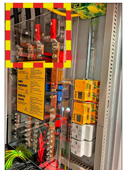
Abb. 29: DC-Leitungen Ladesäule
