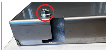
Abb. 47: Detail Verschraubung Heckabdeckung
