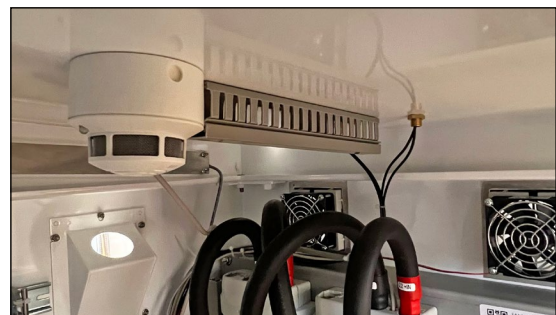
Abb. 39: Position Rauchschalter
