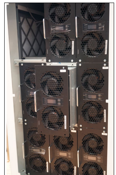
Abb. 63: Ein-Ausbau AC/DC-Module 40kW
