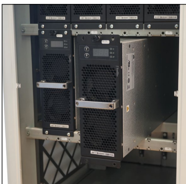
Abb. 73: Einbau Upgrade-AC/DC-Module
